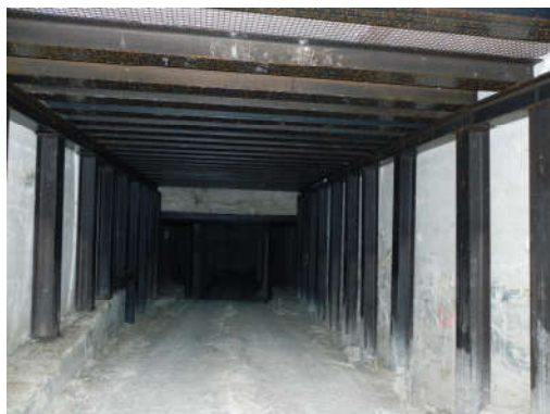
Photo 13: Renforcement de la galerie principale par des poutrelles métalliques
